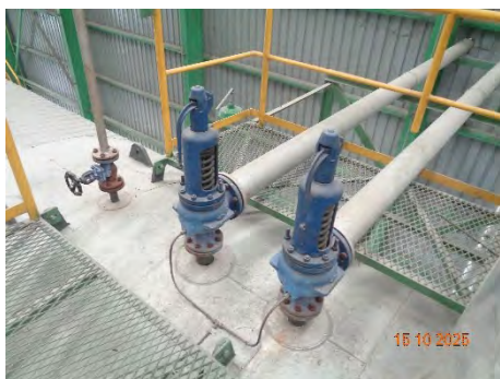
ภาพที่ 2-59 ติดตั้งลื่นนิรภัยกับหน่วยผลิตไอน้ำ
