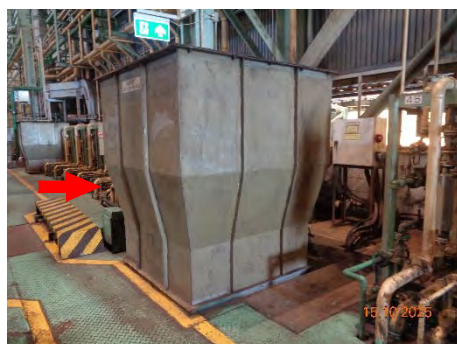
ภาพที่ 2-52 พัฒนาระบายอากาศ บริเวณที่มีอุณหภูมิสูง
