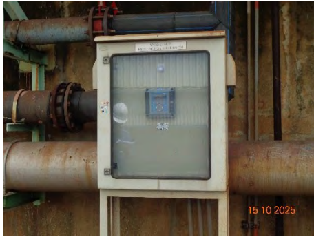
ภาพที่ 2-74 ระบบ DO Monitoring Online บ่อตรวจสอบน้ำเข้าจากหอหล่อเย็น
