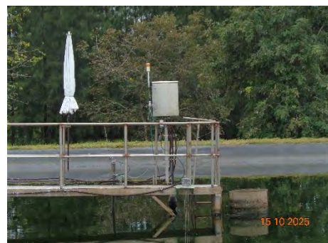
ภาพที่ 2-32 ระบบ COD Monitoring Online บริเวณบ่อพักน้ำทิ้ง (Final Pond)
