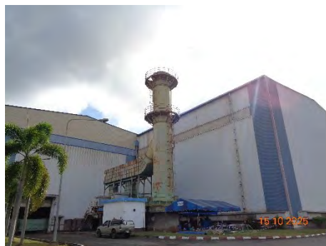
ภาพที่ 2-2 ระบบดักจับไอน้ำมันและปล่อง TCM
