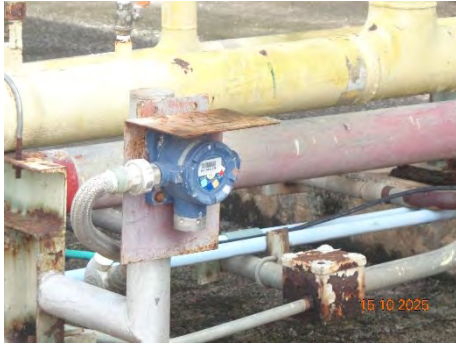
ภาพที่ 2-66 Gas Detector ในบริเวณพื้นที่ถังก๊าซแอลพีจี
