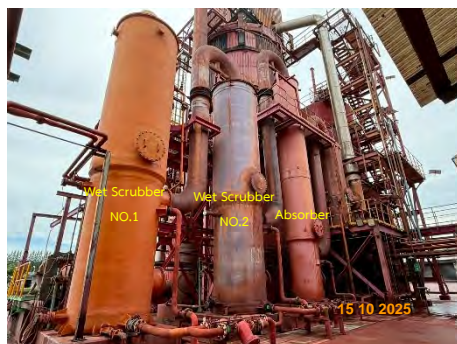
ภาพที่ 2-6 ระบบ Wet Scrubber และ Absorber ที่ปล่อง ARP
