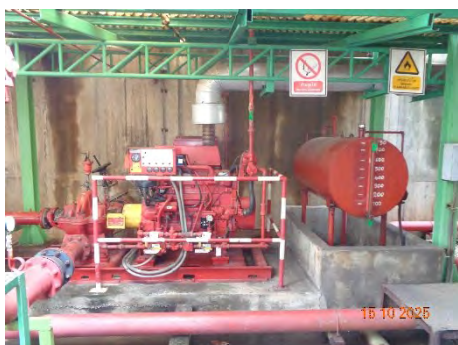
ภาพที่ 2-56 Fire Water Pump ชนิดขับเคลื่อนด้วยน้ำมันดีเซล
