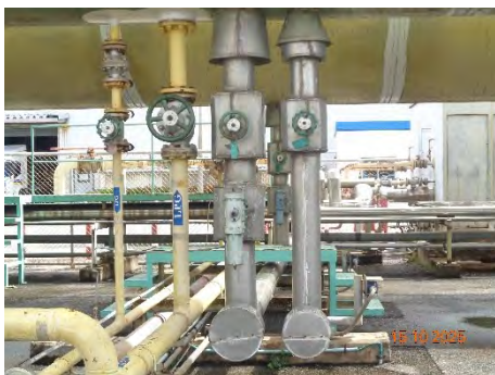
ภาพที่ 2-64 ระบบอัตโนมัติ (Interlock) ของถังก๊าซแอลพีจี
